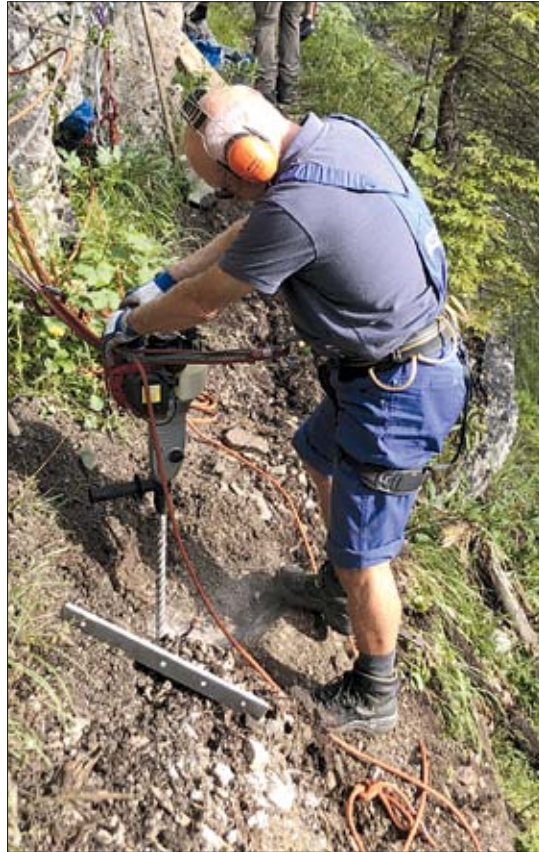
Bohrungen für die neue Haltrung (Foto G. Baumann)
