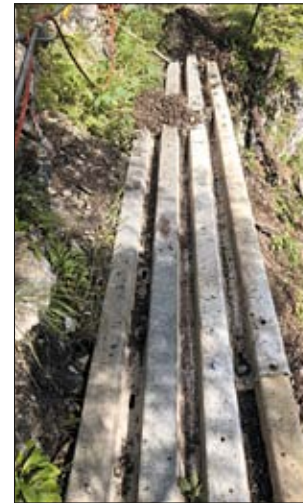
Der Steig im Krottental - wieder sicher
