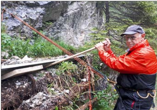
Der alte Unterbau wird stabilisiert (Fotos G. Baumann)
