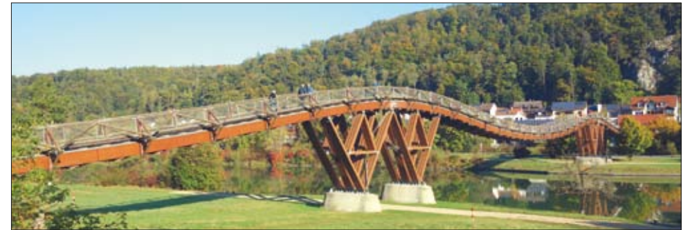
Die Holzbrücke über den Altmühlkanal bei Essing, der „Tatzelwurm“ (Foto razj)
